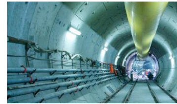
Kadıköy-Kartal Metro Project
