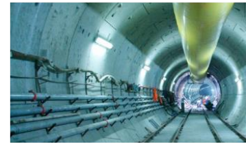
Kadıköy-Kartal Metro Project
