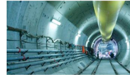
Kadıköy-Kartal Metro Project
