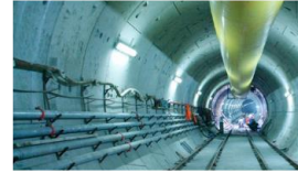
Kadıköy-Kartal Metro Project
