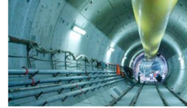
Kadıköy-Kartal Metro Project
