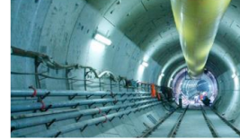
Kadıköy-Kartal Metro Project
